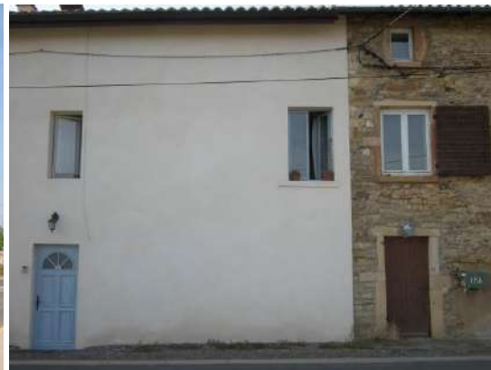
Façade reprise, et menuiseries neuves...
