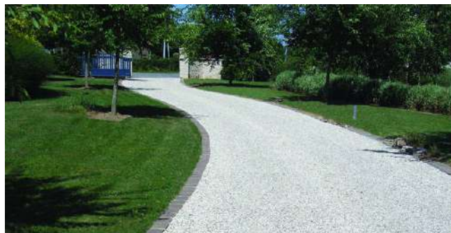
Entrée de garage sol perméable (gravier renforcé)
