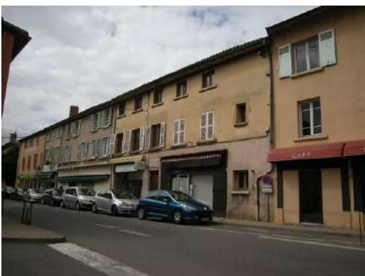
Rue Nationale, immeubles types
