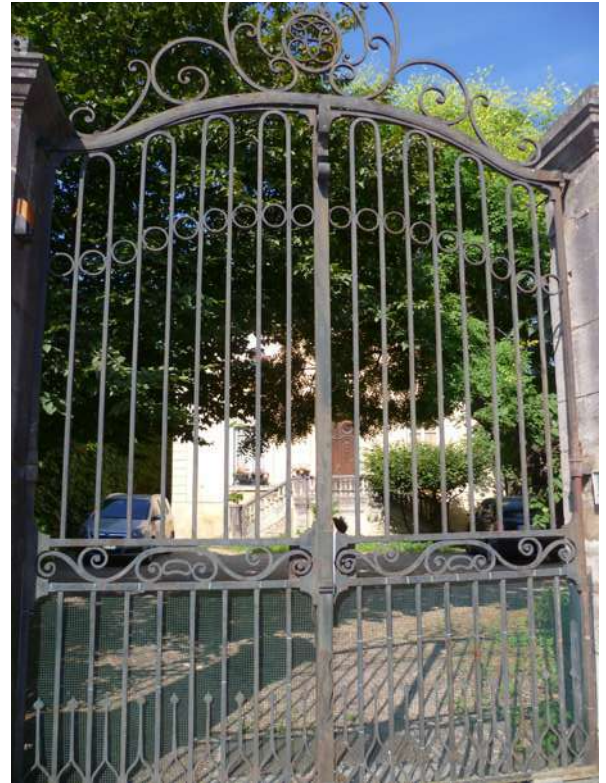
Portail ancien (extensions du 19 e )
