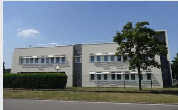
Immeuble de bureau après isolation
