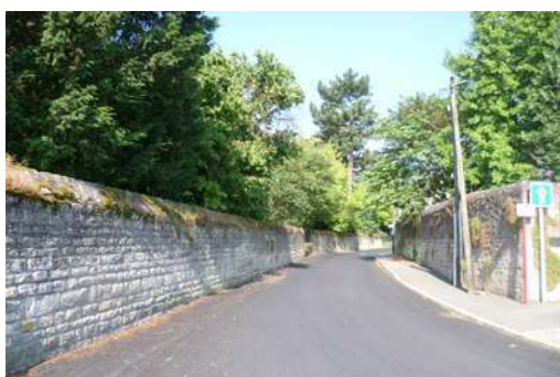
exemple de mur haut en pierre en limite d'espace public à maintenir, Anse
