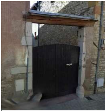
Porche rue du château
