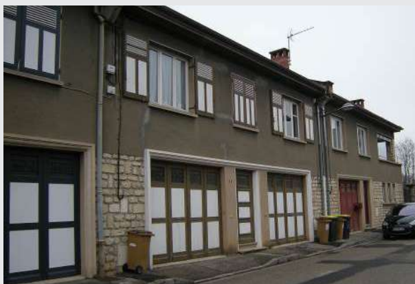
Façade originelle (parement pierre, enduit...)
