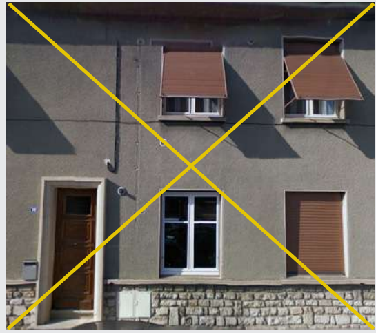
Volets d'origine remplacés par des volets roulants, à éviter
