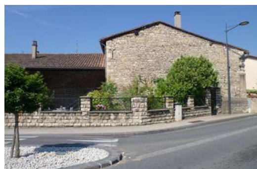
clôture d'origine du quartier de la Libération à maintenir, Anse
