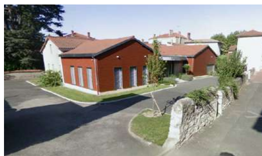
Mur de pierre maintenu dans le cadre d'un projet d'aménagement, Anse
