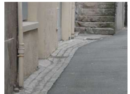
pavés en pieds de façade
